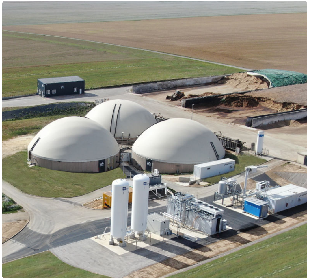
Unité de méthanisation SAS Chemin du Roi
